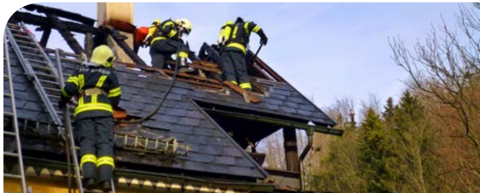
Brand Wohnhaus in Anzenau
