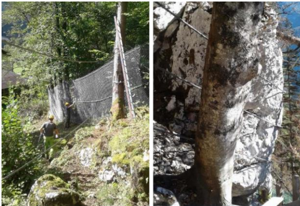
Abbildung 219: Links: Mobiles Steinschlagschutznetz zur Erstabsicherung der Wohnobjekte unterhalb der Echernwand. Rechts: Sicherung eines Felskopfes mittels Anker in der Echernwand © Bild: WLW
