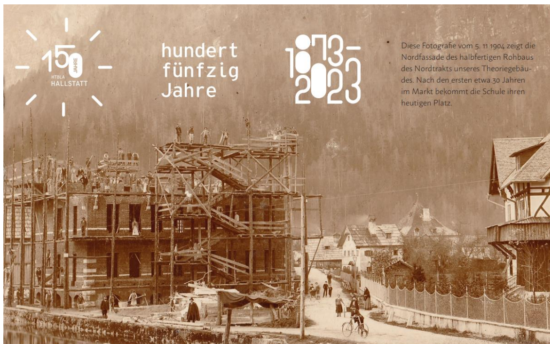
Abbildung 264: Rohbau des Nordtrakts des heutigen Theoriegebäudes. Fotografie vom 5. November 1904. © Bild: HTBLA Hallstatt
