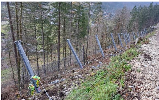
Abbildung 223: Linkes Bild: Errichtung von Steinschlagschutznetzen unterhalb der Echernwand. Die Fertigstellung erfolgte im Jahr 2022. Rechtes Bild: Errichtung von Steinschlagschutznetzen oberhalb des Ortsteils Römischen. Die Fertigstellung erfolgte im Jahr 2023. © Bilder: WLV und Janu
