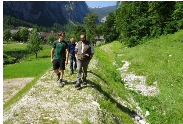
Abbildung 220: Steinschlagschutzdamm als Sofortmaßnahme für die Wohnobjekte im Bereich unterhalb der Echernwand. © Bild: Janu
